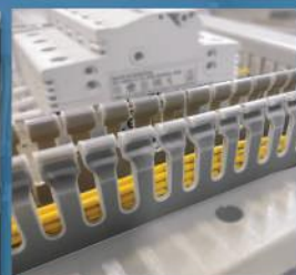
รูปแบบการใช้งานราวสายดักส์ในตู้คอนโทรล
